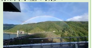
味噌川ダム堤体に架かる二重の虹(R5.10.5 撮影)
